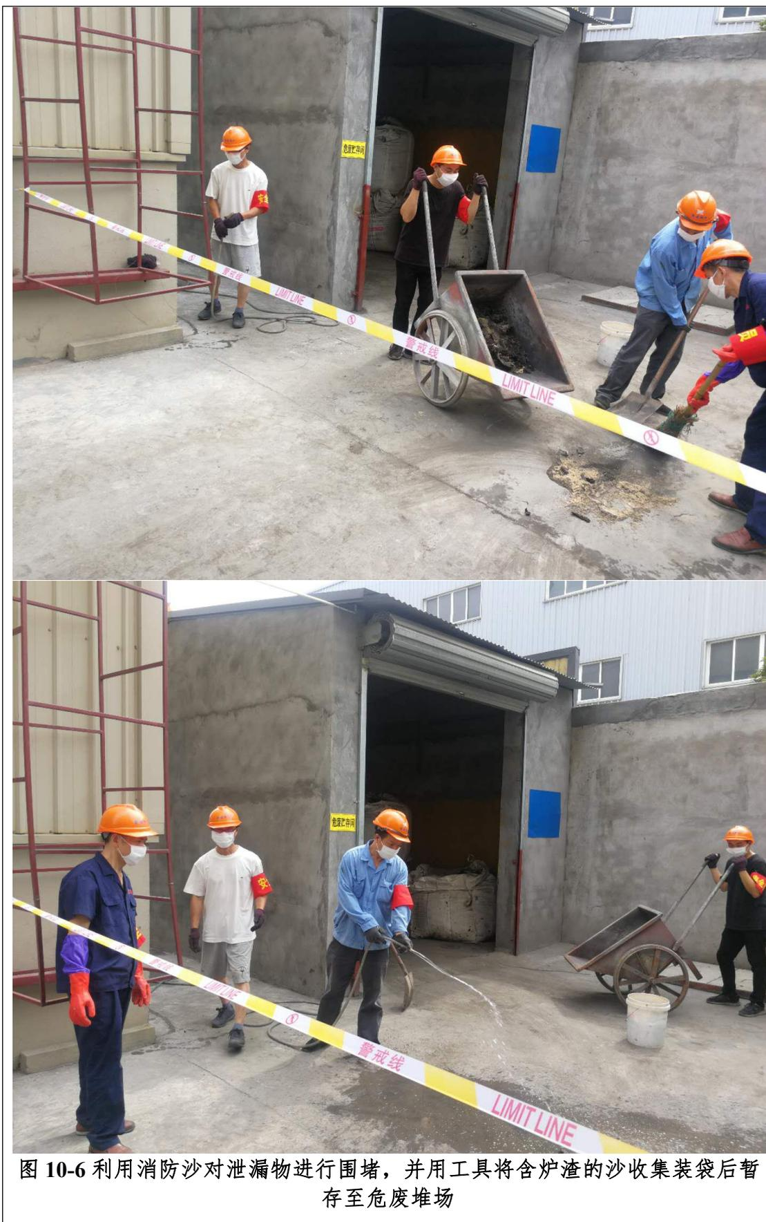
图 10-6 利用消防沙对泄漏物进行围堵，并用工具将含炉渣的沙收集装袋后暂存至危废堆场
