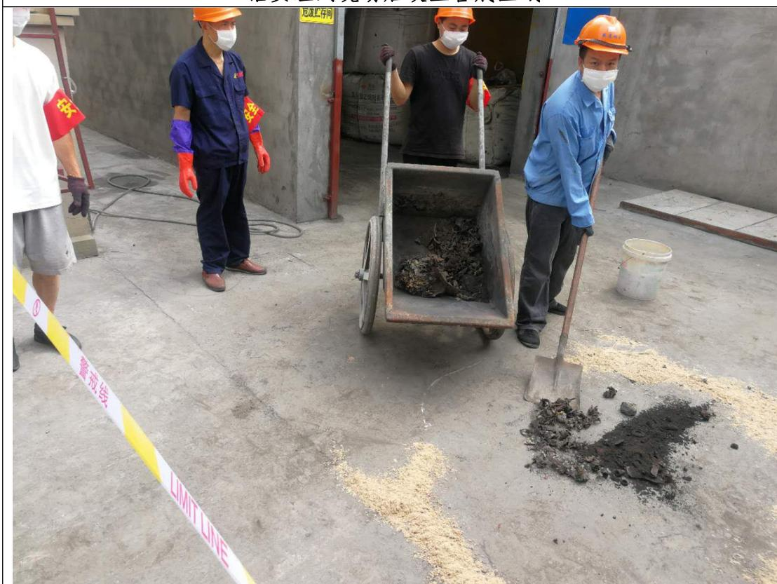
图 10-4 应急抢险人员到达现场，利用消防沙对泄漏区域设置围堵
