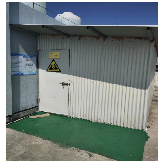
危废堆场外景
