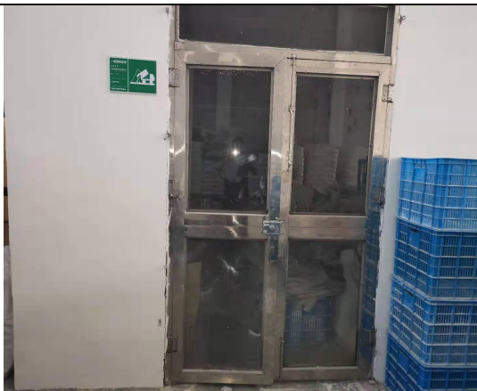
一般固废堆场
