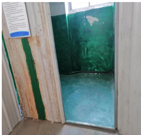
危废堆场内景
