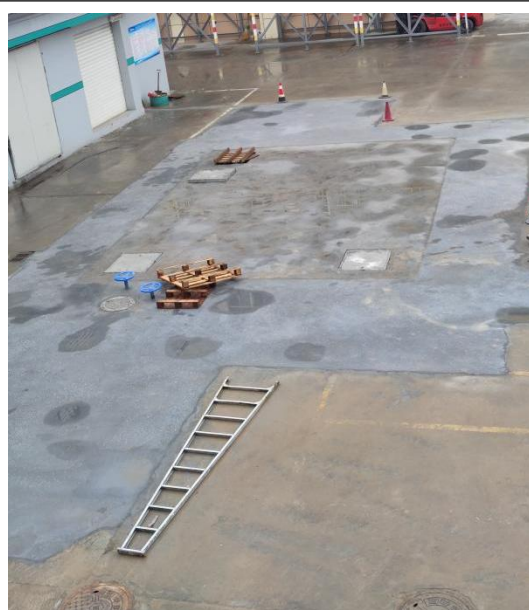
初期雨水收集池
