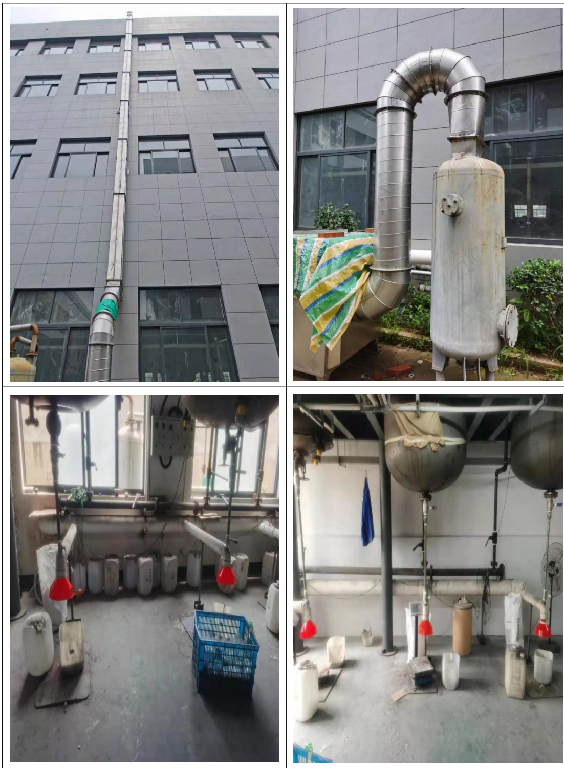
附图 4 现场部分照片
