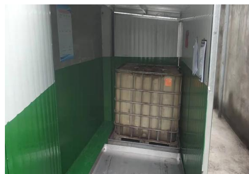
危废堆场 2 内景
