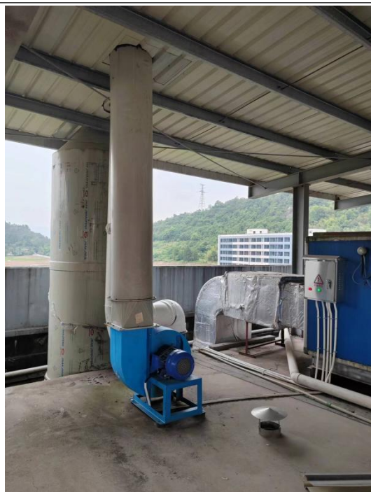
加硬烘干废气（南）废气处理设施
