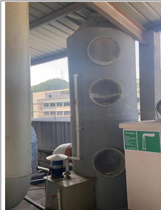
加硬烘干废气（北）废气处理设施
