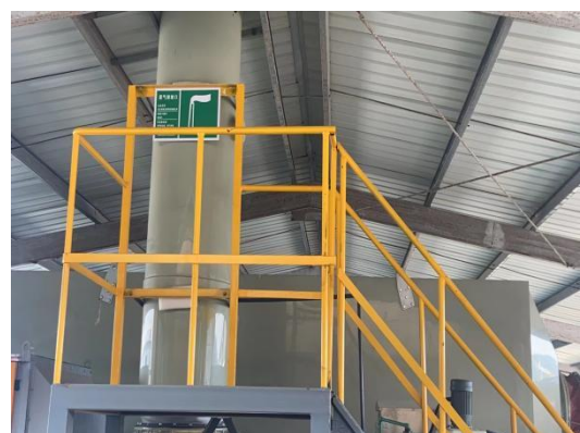
浇注固化废气处理设施
