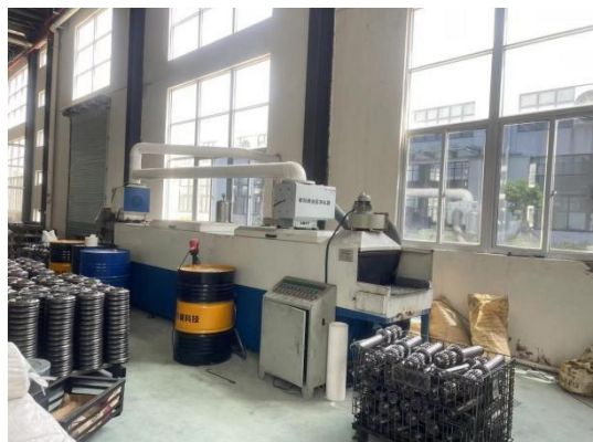
清洗机废气收集处置
